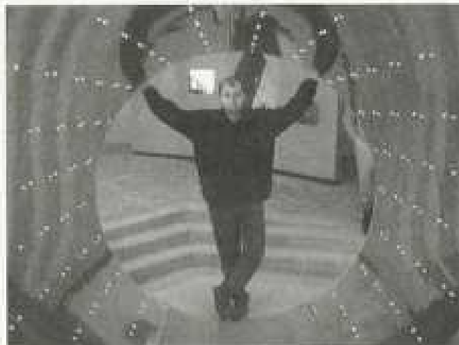
Le diamètre de ce tube (guide d'ondes) correspond à celui de l'ouverture au centre de l'antenne parabolique (2m.)
