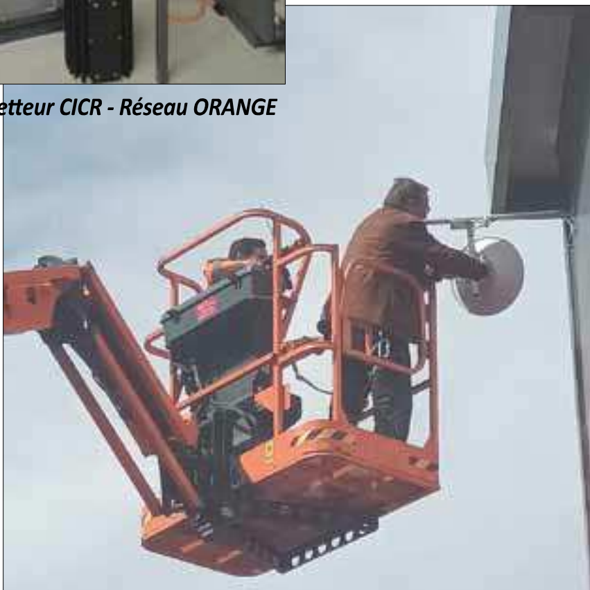
HB9DSB aligne antenne parabolique link 5 GHz vers Dailly
