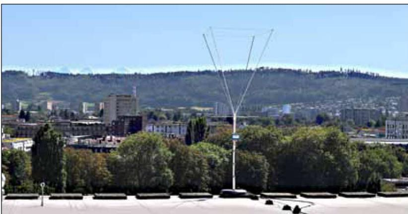
Fig 2: Système de réception placé sur le toit de la Halle de gymnastique du Gymnase des Alpes à Bienne. Un préamplificateur est placé directement sur le mât de l'antenne pour gagner en qualité de signal.
