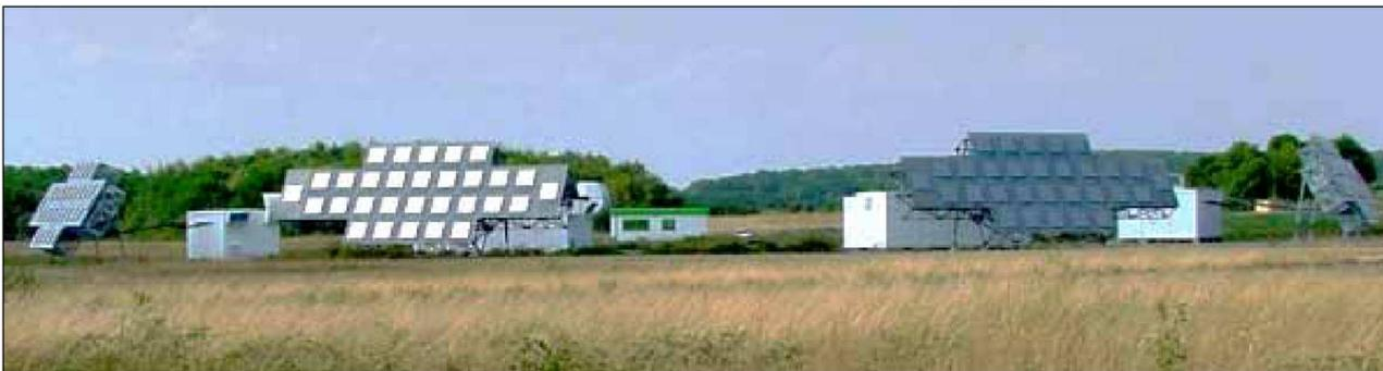
Fig. 1: Emetteurs du radar GRAVES, situé entre Dijon et Vesoul; Fréquence d'émission à 143.05 MHz.
